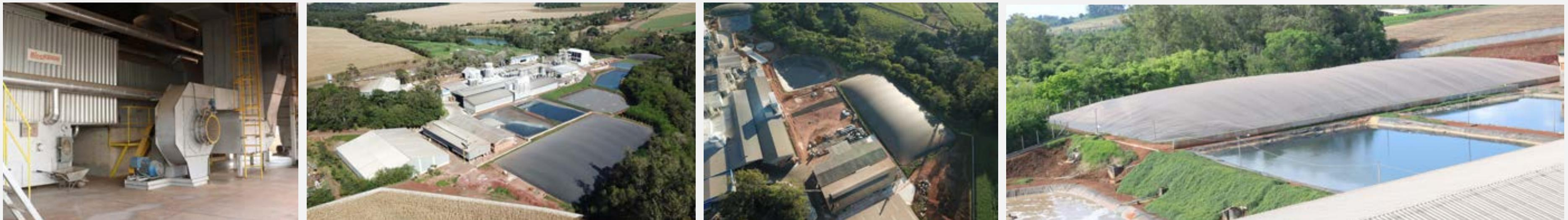
Em 2024, a Agrícola Horizonte Ltda. – Amidos implantou uma Estação de Tratamento de Efluentes (ETE) moderna e sustentável, com capacidade de 180 m<sup>3</sup>/h, superdimensionada para garantir alta eficiência no tratamento biológico. O sistema utiliza processos naturais, sem adição de produtos químicos na maior
